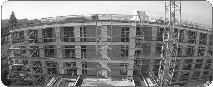
Der Neubau "Haus Feld" ist auf Kurs und sollte im September 2022 fertig sein. (Foto webcam)
